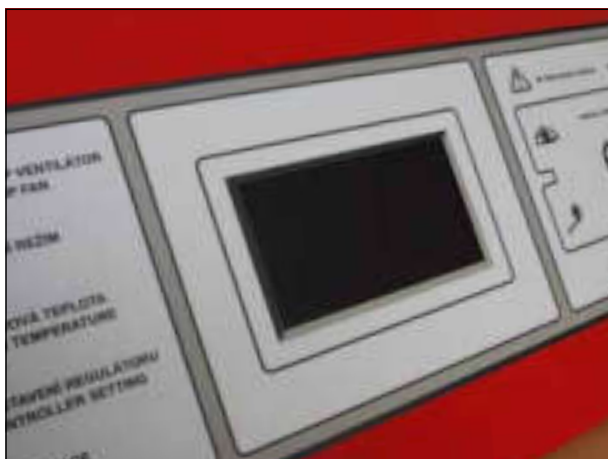
Regulátor v přístrojové kapotě kotle
