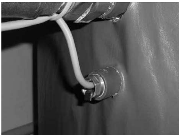
Obr. 13 - pohled na čidlo teploty vody v jímce akumulční nádrže (TV a TS)
