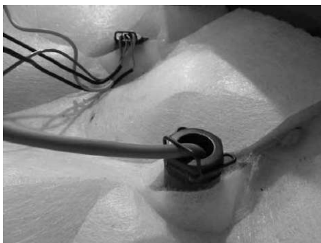
Obr. 16 - pohled na čidlo teploty vody TK v jímce kotle typ DxxP, Pxx
