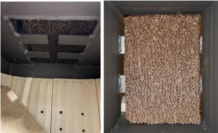
*Katalysatoreinbau oberhalb des Kugelfangs hinter der Rauchumlenkplatte für M, Maestro, QM40 ecoline*
