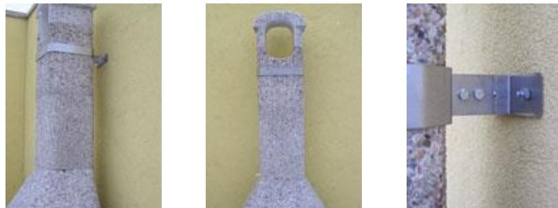
**Příklad uchycení komínového dílu sponou na trámovou konstrukci pomocí šroubů do dřeva pr. 8 mm s šestihrannou hlavou**
